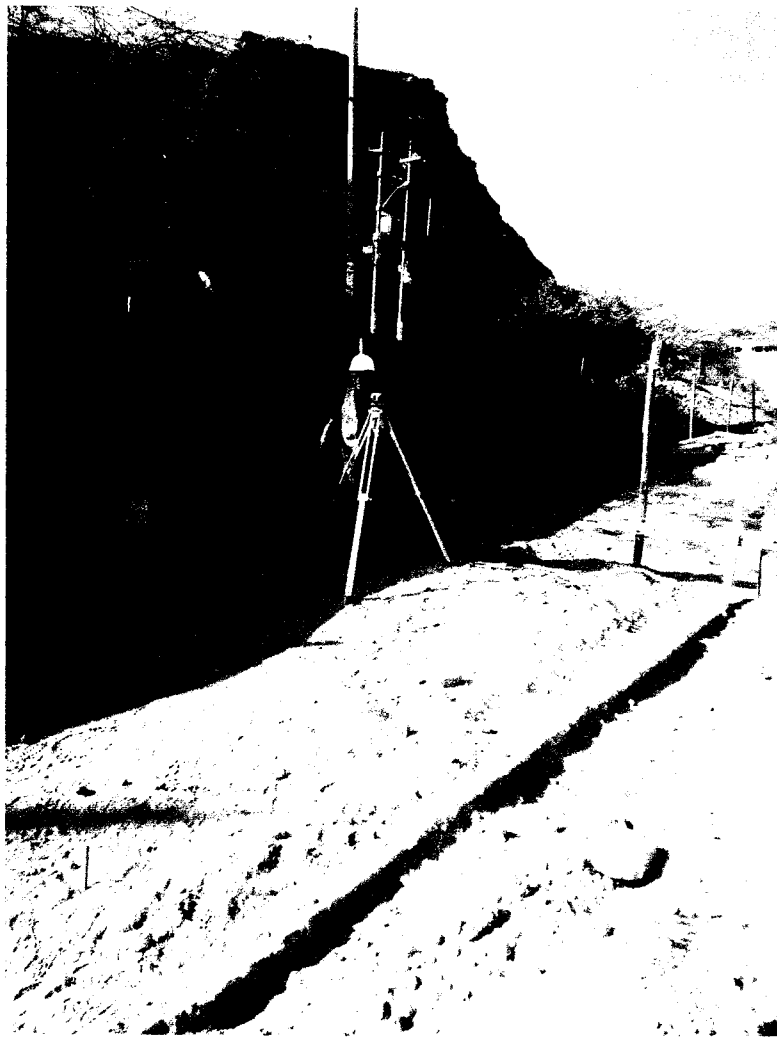
TRAZO Y REPLANTEO CON NIVEL TOPOGRAFICO
