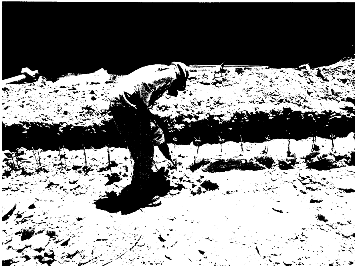
VARILLA EMPOTRADA EN EL CIMIENTO CORRIDO
