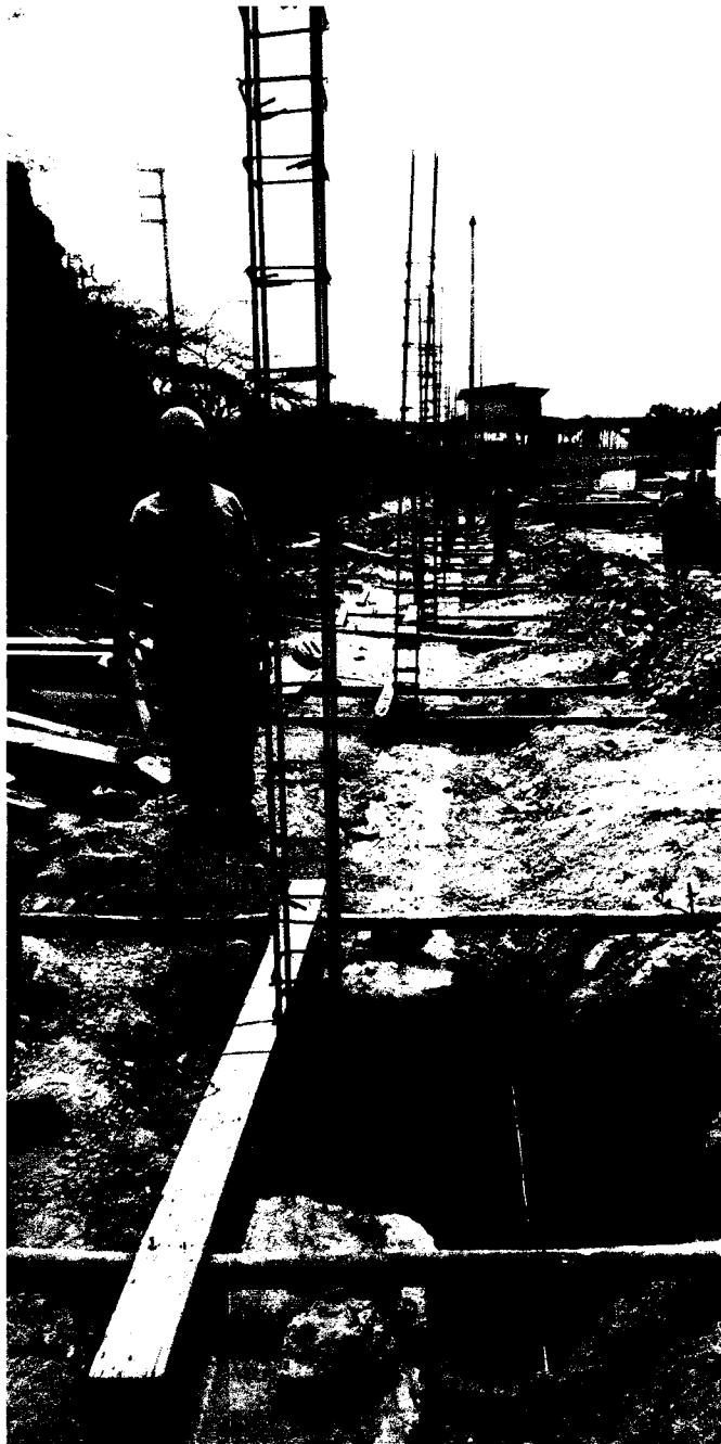
IZAMIENTO DE COLUMNAS
