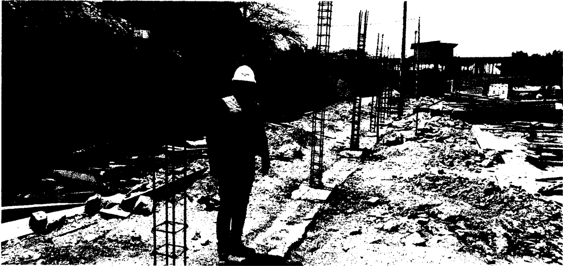
HABILITACION DE COLUMNAS
